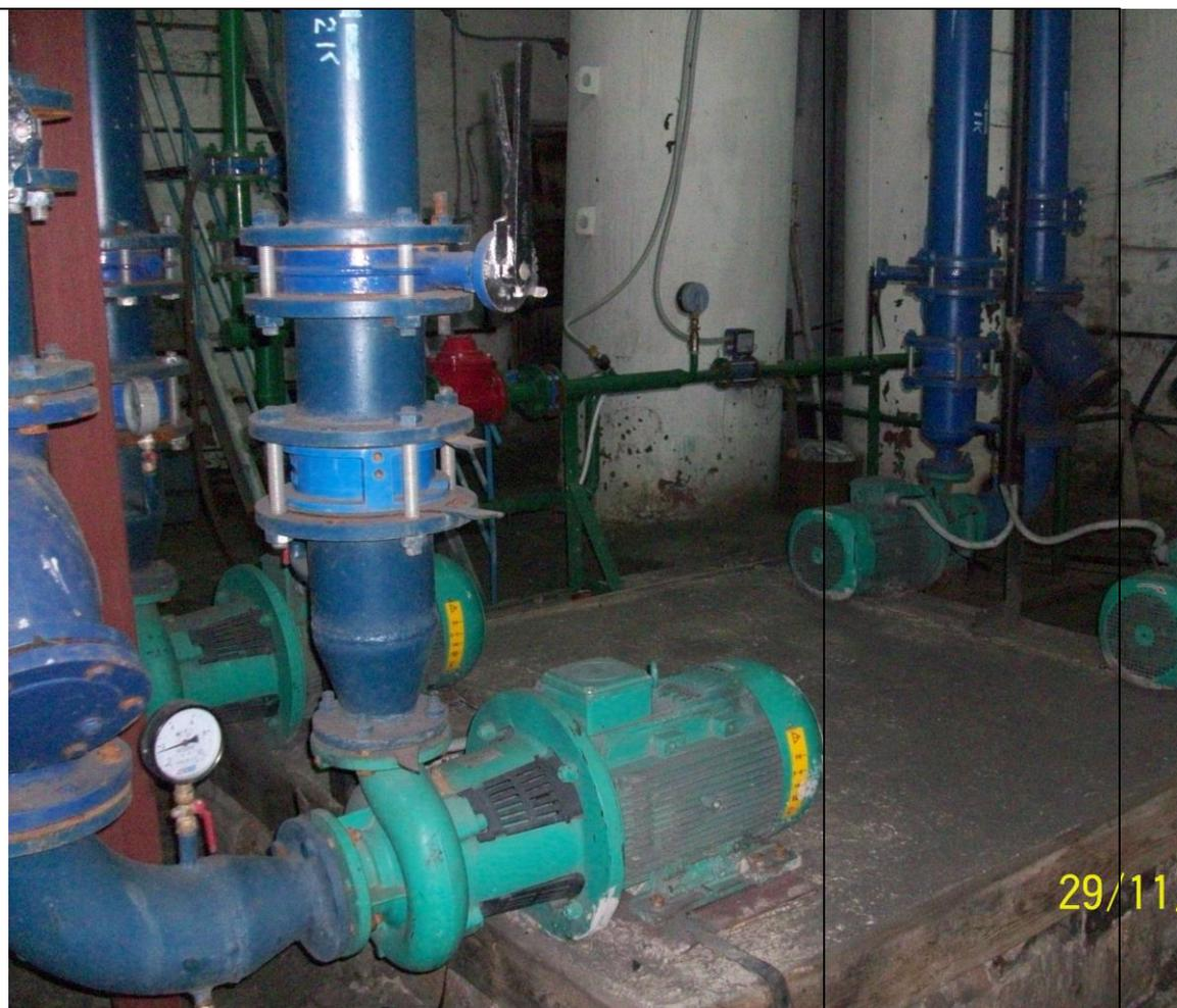
Система теплоснабжения двухтрубная. Отопления осуществляется по одноконтурной системе
